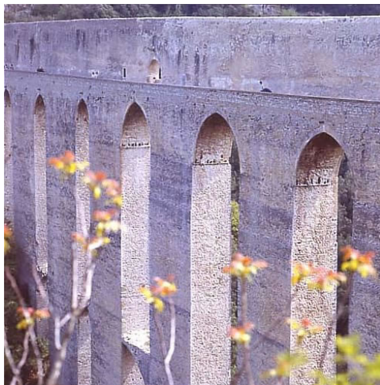
Ponte delle Torri
