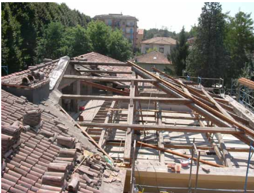
Rifacimento della copertura
