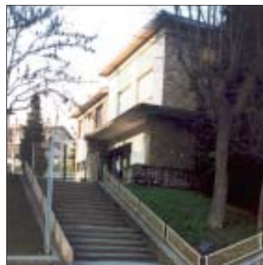
Comune di Prignano sulla Secchia, progetto di recupero dell'ex scuola elementare.
