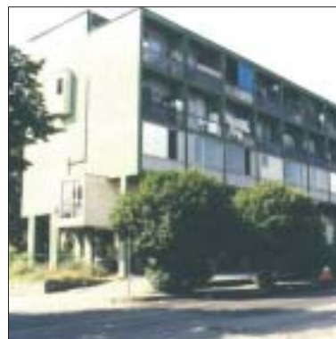
Comune di Sassuolo, progetto di risanamento del "Condominio di San Matteo".
